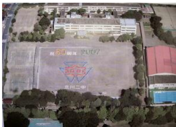
校舎の全景（平成19年）
