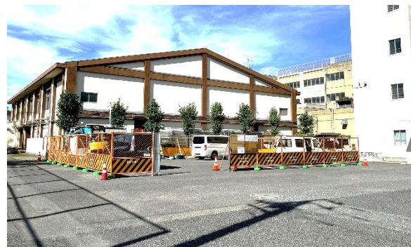
体育館前の工事ヤード
